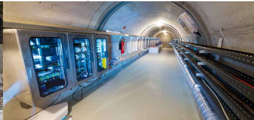
Seismisch-gravimetrischer Teil des Observatoriums The seismic-gravimetric section of the observatory
